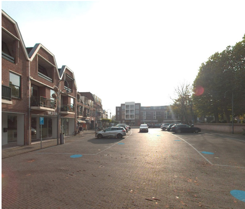
■ Bestaande situatie Hortuslaan Sassenheim
