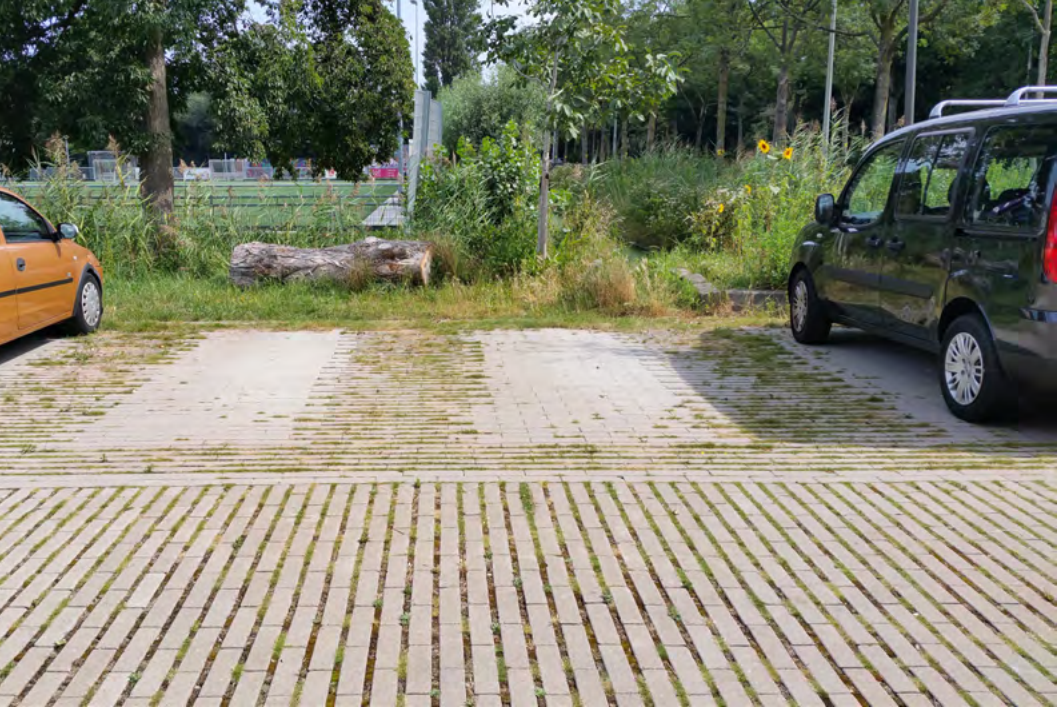
Parkeerterrein met waterdoorlatende verharding
