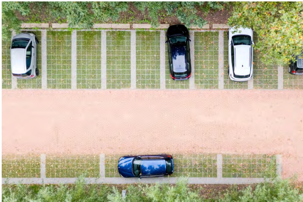
Parkeerterrein met waterdoorlatende verharding
