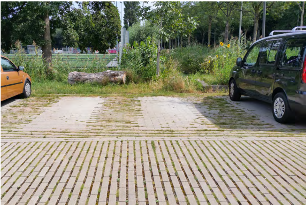
Parkeerterrein met waterdoorlatende verharding
